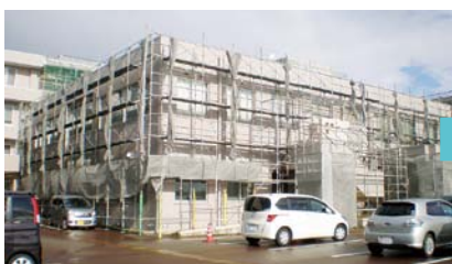
外壁工事の様子
